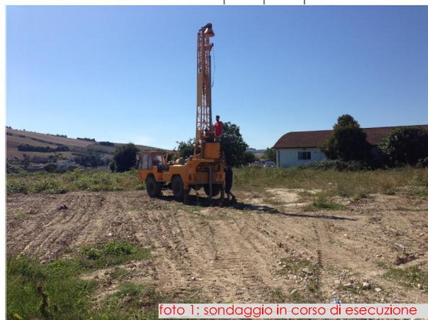
foto 1: sondaggio in corso di esecuzione
