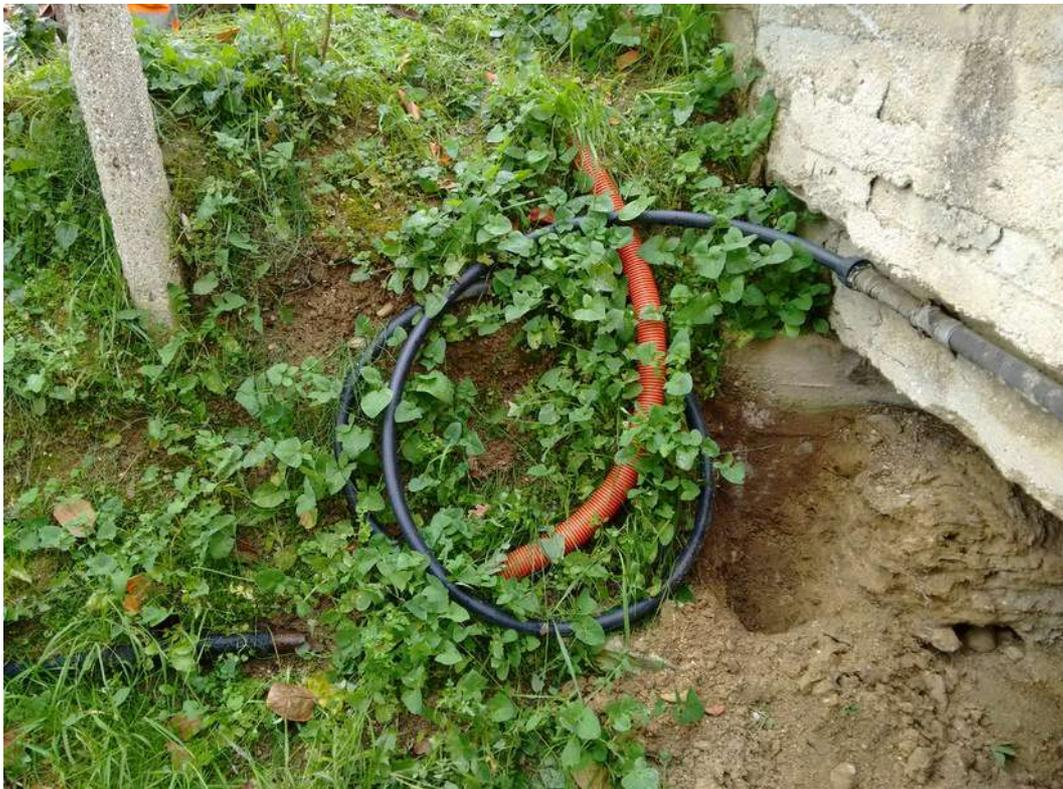
**Foto 5.1.2: Fosso Monte Marino B – ripresa della condotta in PEAD aggrovigliata a terra all'uscita del sottopasso della SS16.**
