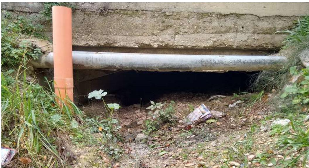
**Foto 5.2.1: Fosso Monte Marino A – ripresa della condotta che ostruisce parzialmente la luce libera di deflusso del sottopasso della SS16.**
